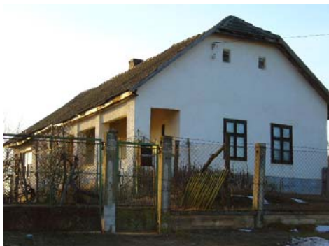
lakóépület Petőfi utca 109. 54. hrsz
