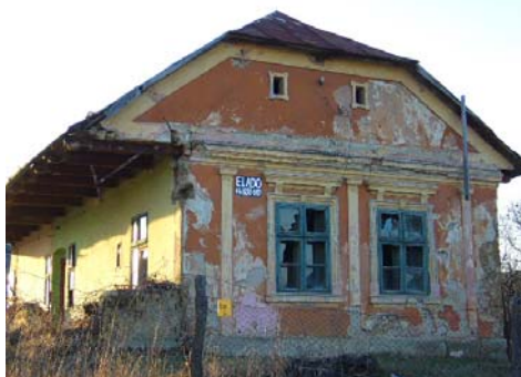
lakóépület Petőfi utca 92. 100. hrsz
