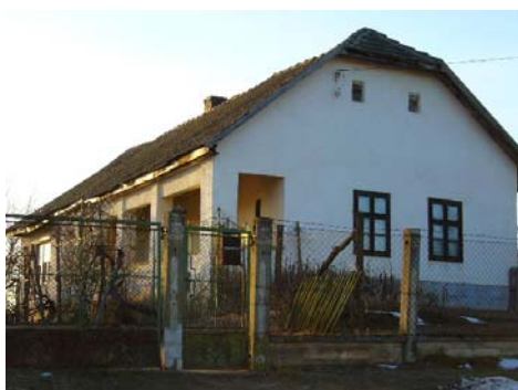
lakóépület Petőfi utca 109. 54. hrsz
