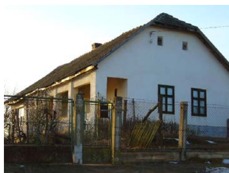
lakóépület Petőfi utca 96. 98. hrsz
