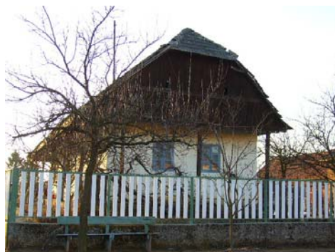
lakóépület Petőfi utca 78. 107. hrsz.
