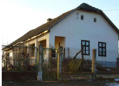
lakóépület Petőfi utca 96. 98. hrsz
